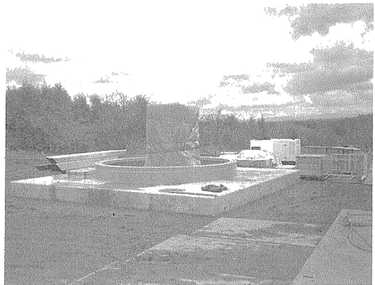
写真—4 制御板据付け
