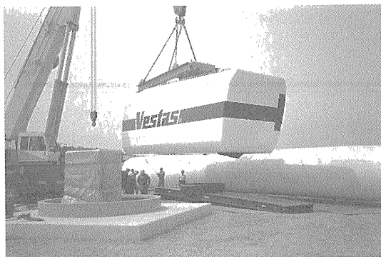
写真—7 ナセル吊上げ
