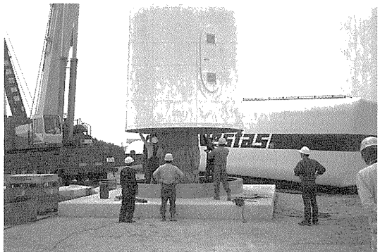
写真—5 タワー（下部セクション）据付け
