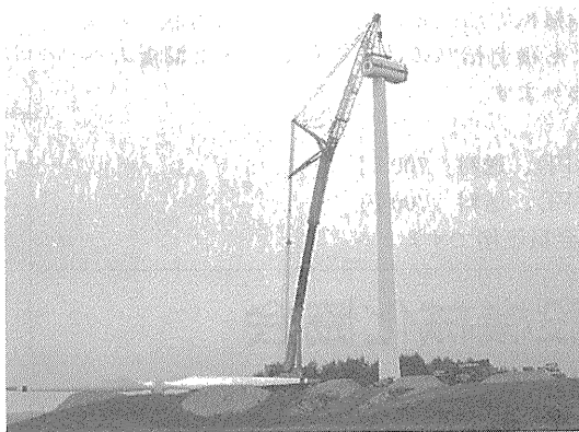
写真—8 ナセル取付け
