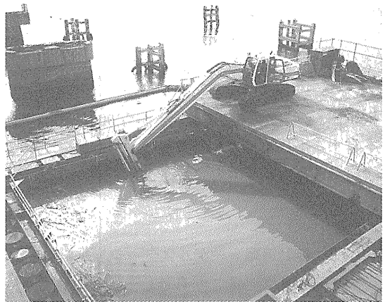
写真—3 解体状況
