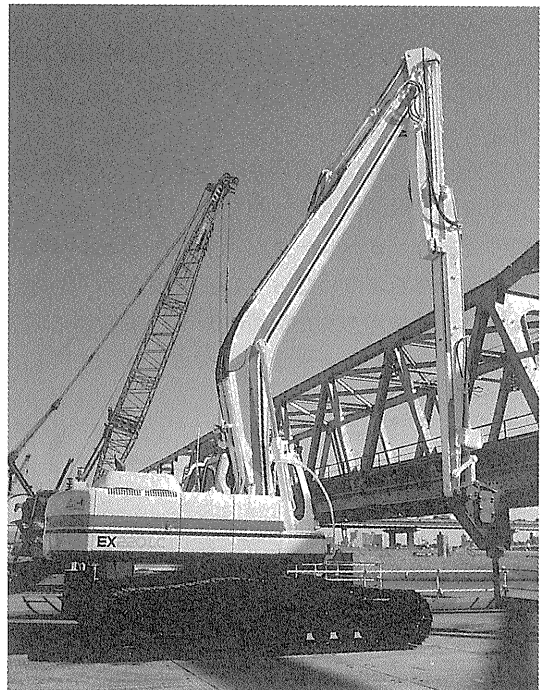
写真—1 デメテル工法機
