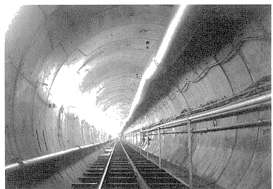
写真—6 施工完了区間 (1)
