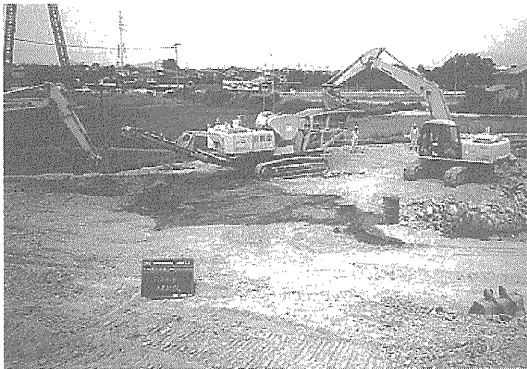
写真—5 破碎機による2次破碎状況
