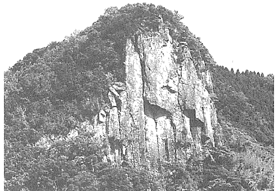
写真-1 坑口上部の巨大岩塊
