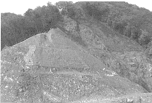
写真—10 法面保護工
