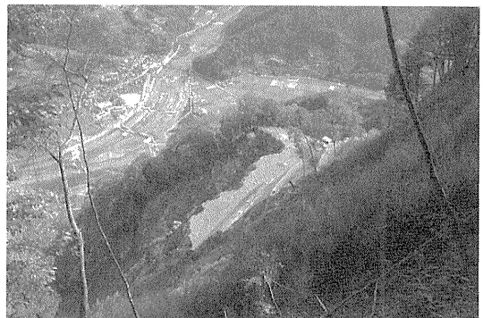
写真—13 切取り・4段目完了
