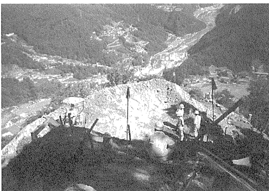
写真—5 組立てヤード
