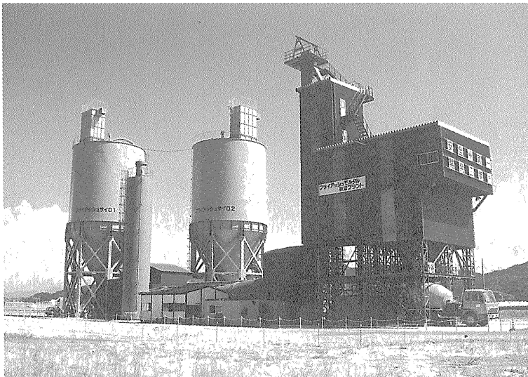
写真—1 プラント全景
