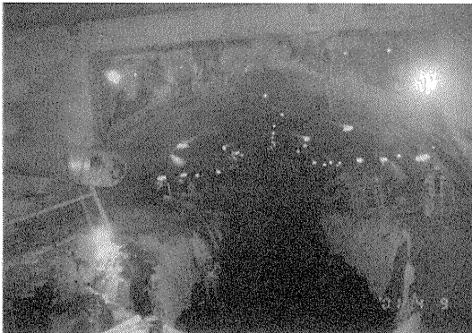
写真-20 地下鉄工事現場
