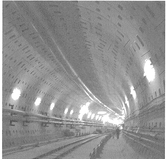
写真一 坑内（インバート施工済み区間）
