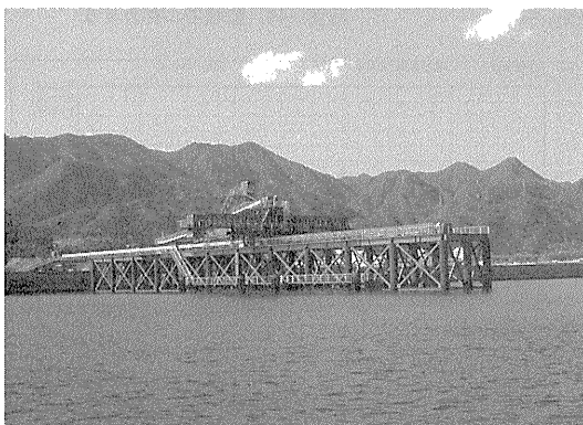
写真—10 船積み栈橋
