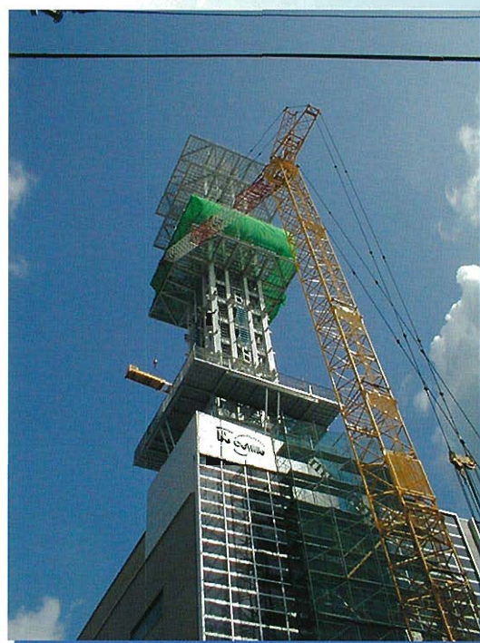
⇩ プラットフォーム部材揚重状況
