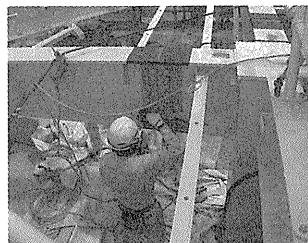
写真11 プラットフォーム構台上作業
