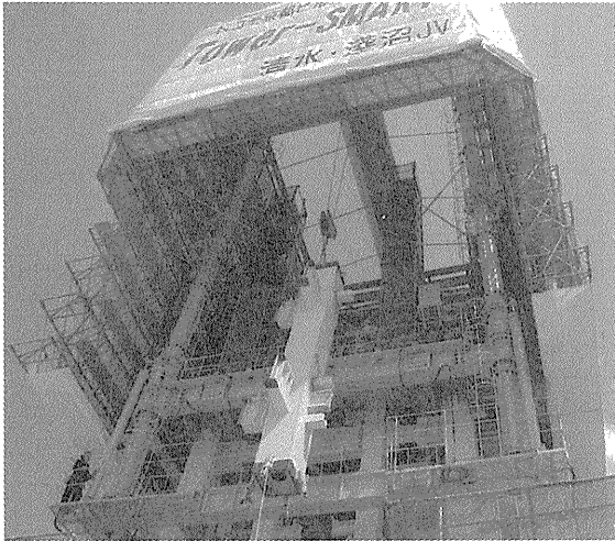
写真—2 荷取構台からシステムによる揚重
