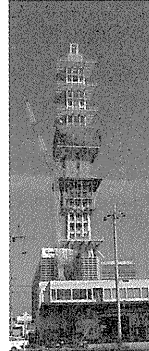
10/5 J 面部材搬入取付
