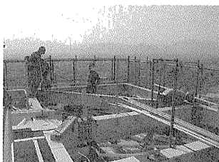
写真10 プラットフォーム取付け作業
