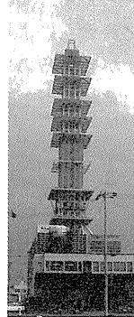
10/13 G 面部材搬入取付
