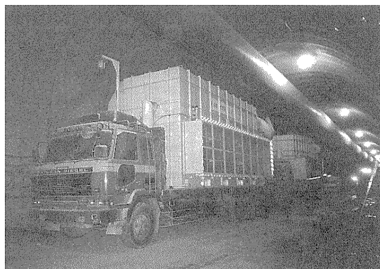
写真-13 電気集塵機の設置状況
