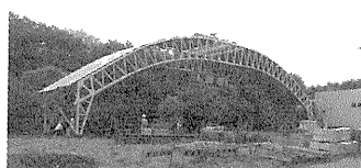
写真—4 緊張完了
