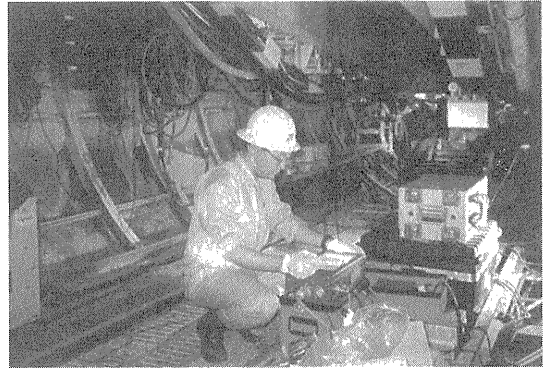
写真1 TBMでの反射トモグラフィ実施状況
