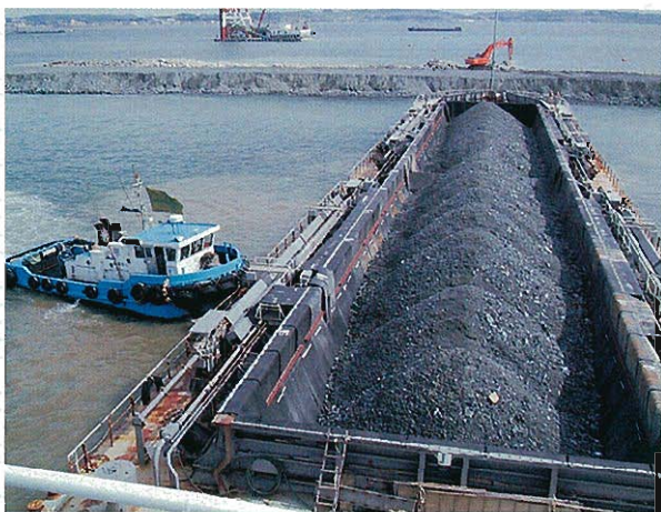
⇩底開式土運船直投位置決め状況
