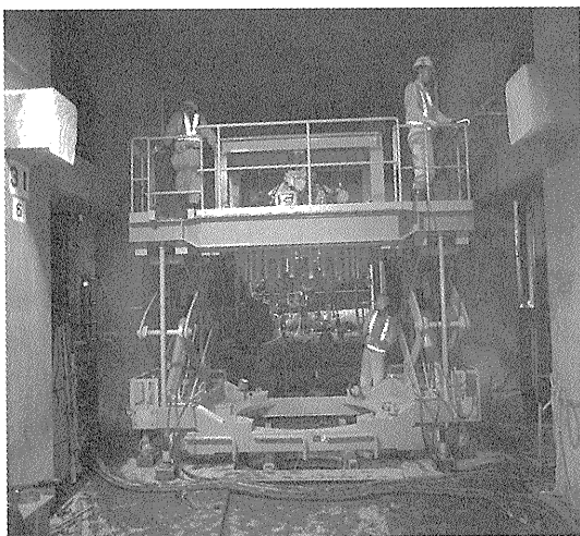
写真—1 ストランド建込み装置
