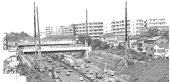
写真-1 現場全景
