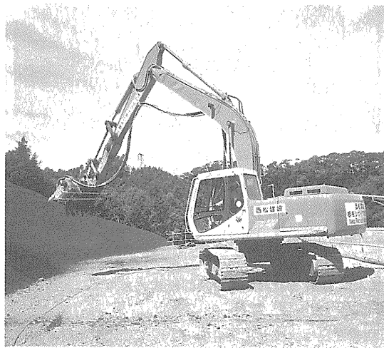
写真-23 施工中のバックホウ 先端バケットに装着した回転式ノズル「シゲル君」
