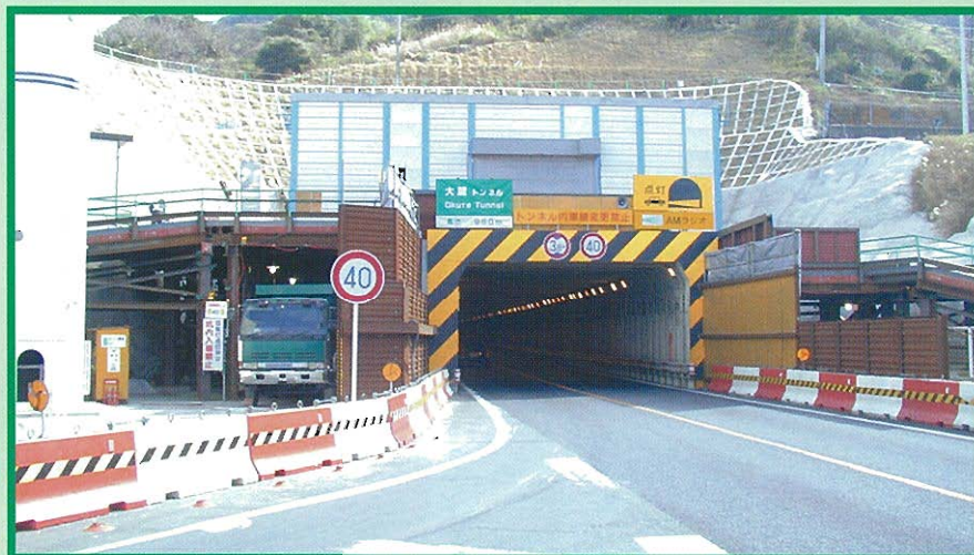
⇧ トンネル坑口部の仮設備
