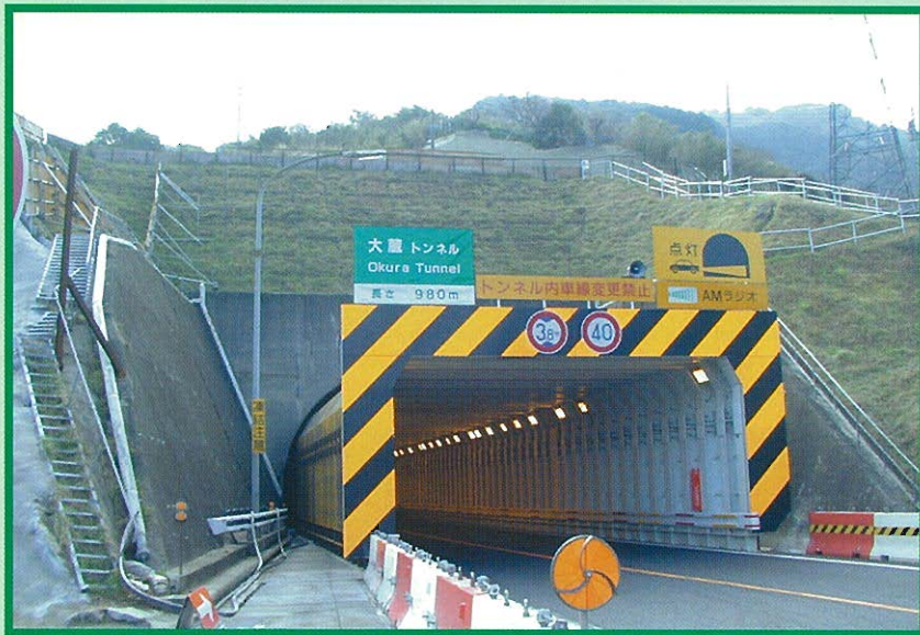
⇩ プロテクター設置直後の大蔵トンネル坑口
