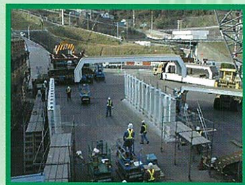
⇩ プロテクターの組立状況
