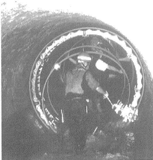
写真-6 製管状況（自走式）
