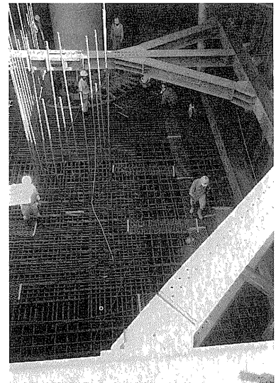
写真-3 配筋状況
