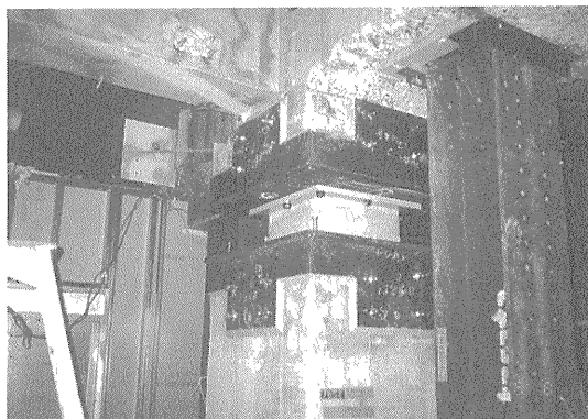
写真—5 積層ゴム取付け状況
