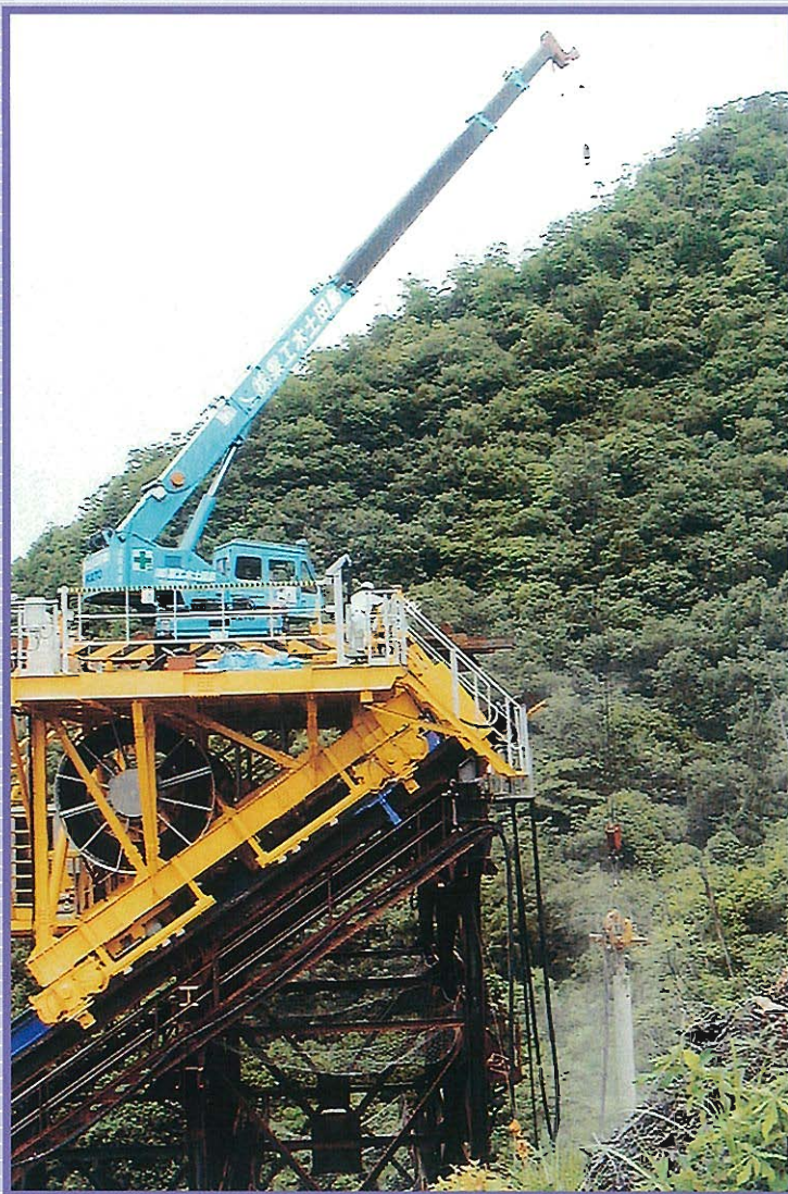
⇧ 架台敷設作業中 (横方向より撮影)
