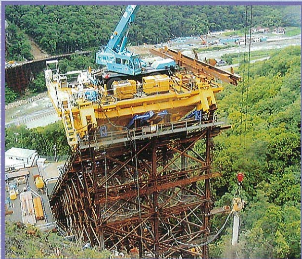
⇨架台敷設作業中(前方より撮影)
