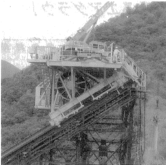
写真—1 架台施工状況
