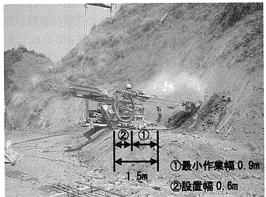
写真-5 最小足場幅の現場実験
