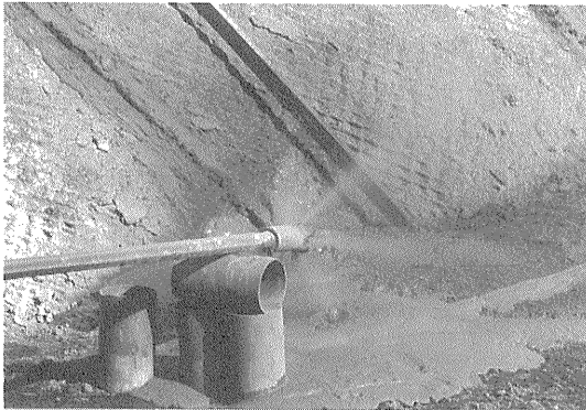
写真—1 セメントミルクとエアの噴射状況
