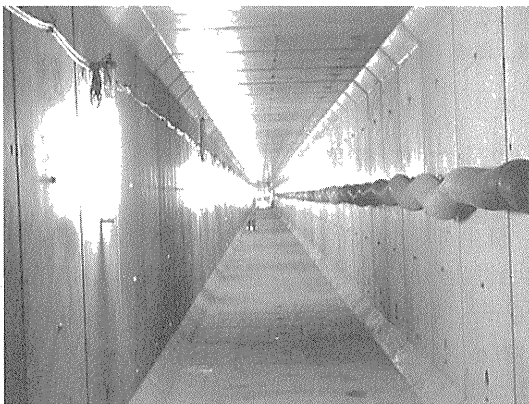
写真一七 側道部推進洞道内部
