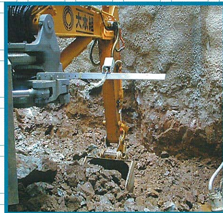
↑バケット掘削状況
