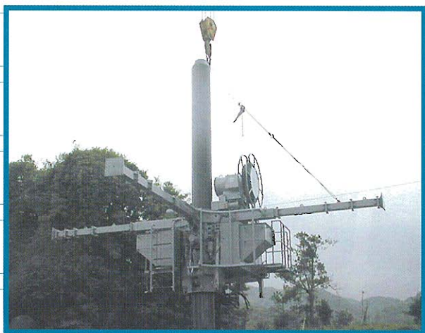
↑機械組立③:油圧ユニット部
