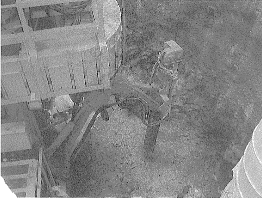
写真—2 削孔状況
