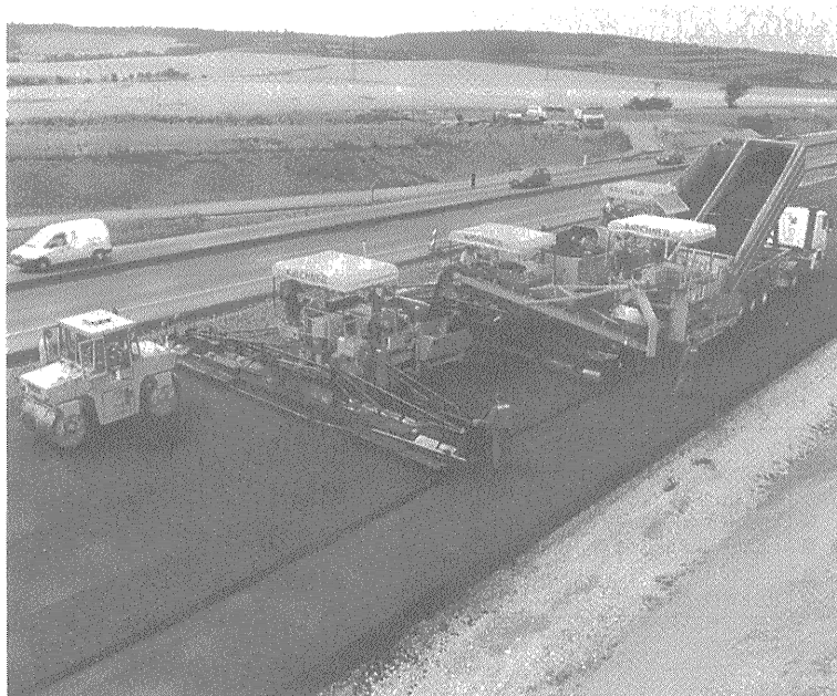
写真一 コンパクトアスファルトの施工状況
