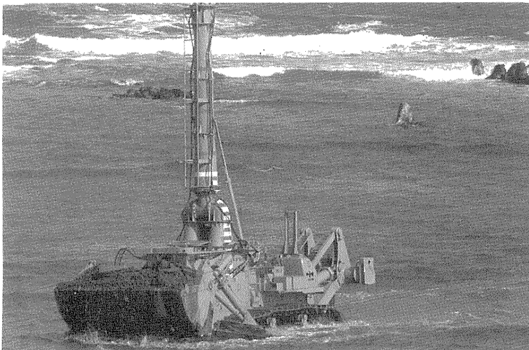
写真-1 エプロンによる掘削作業状況
