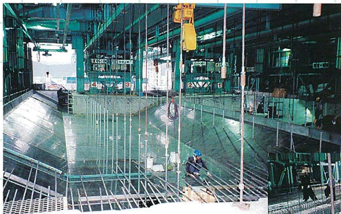
⇩型枠組立状況
