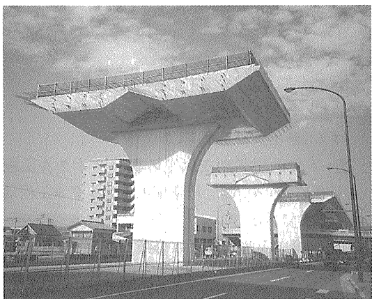
写真三 全断面柱頭部
