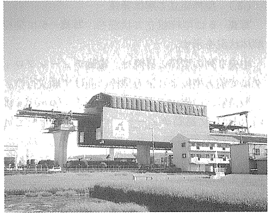
写真-4 大型移動支保工移動状況
