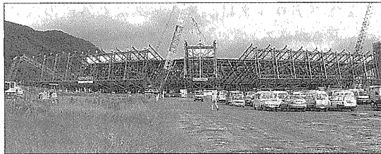
写真-5 地切り完了外観
