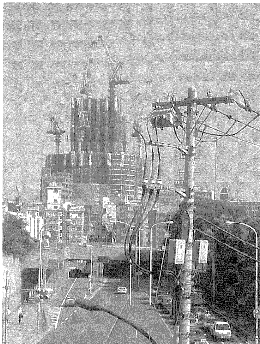
写真—3 建設中の六本木ヒルズ, 撮影: 池村圭造, 2001年9月
