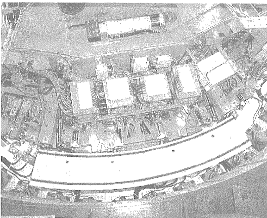
写真-5 セグメント自動組立てロボット 3)
