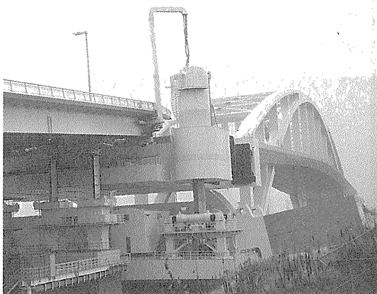
写真-6 反力壁倒伏動作の完了
