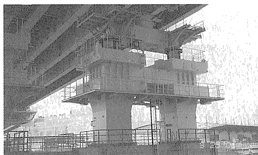
写真-4 主ジャッキアップ装置
