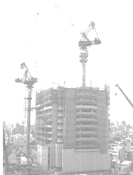
写真—2 外部と内部に設置されたタワークレーン
