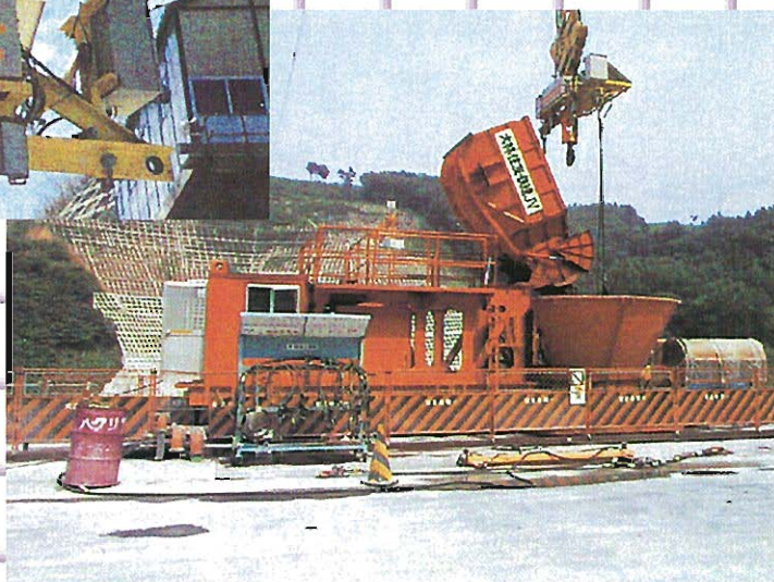
⇩トランスファーカ運転状況
