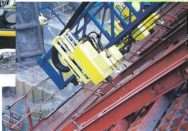
◆ボルト締結作業
