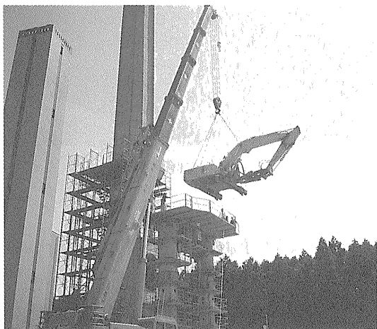
写真—2 コンクリート破砕機設置
