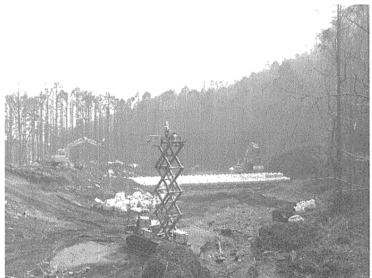
写真三 施工状況
