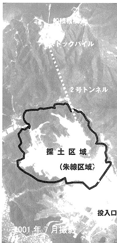
写真-2 加太土砂採取事業全景写真
