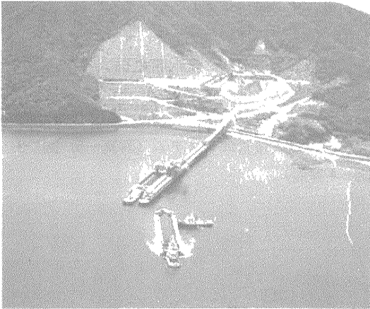
写真一4 積出橋橋船積み状況
