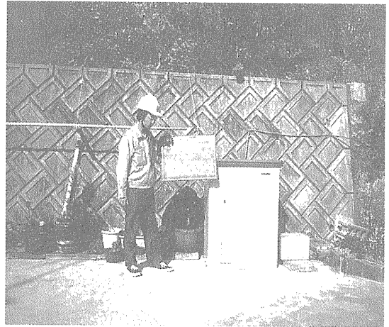
写真-1 計測機器設置状況 (外観)
