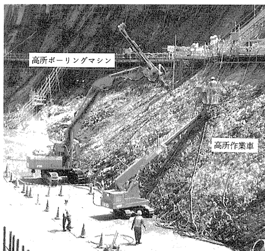
写真-2 施工状況
