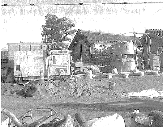
写真一2 プラント設置状況
