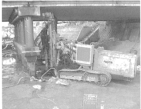
写真一4 削孔状況
