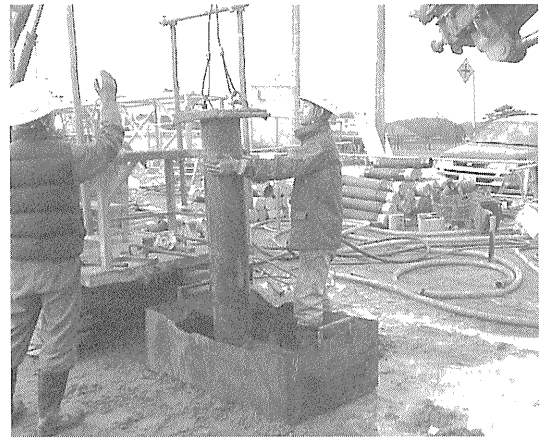
写真一3 鋼製ピットおよびガイド管
