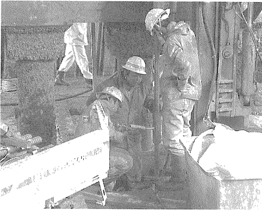
写真一五 鉄筋挿入状況
