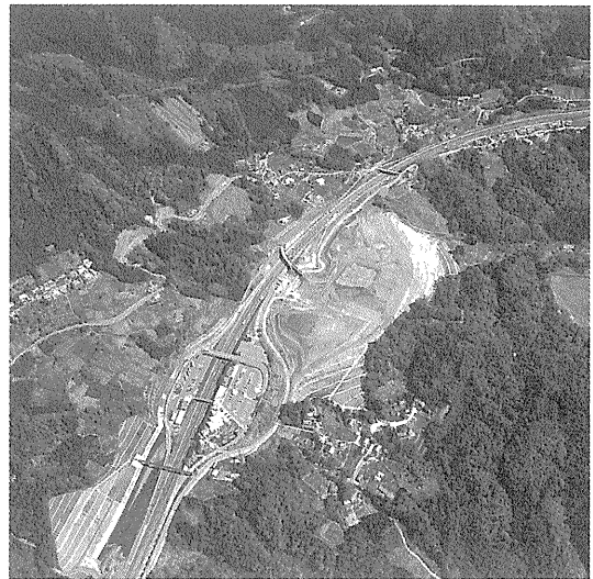
写真-1 談合坂SA(上り)大規模盛土状況(平成11年10月)(甲府方面より東京方面を望む)
