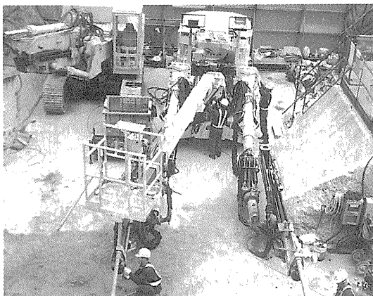
写真-1 穿孔機械全景
