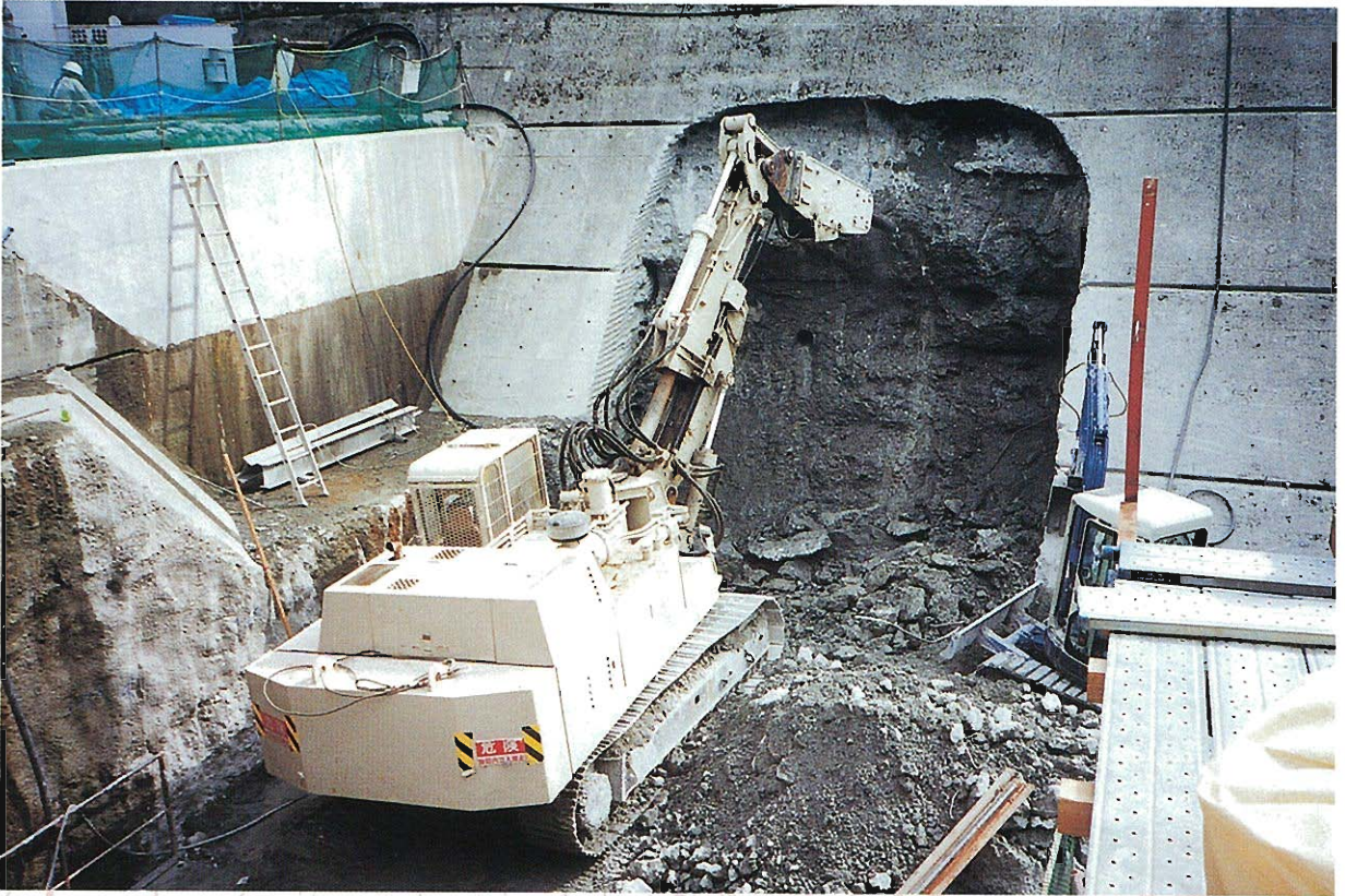
⇧ ブレーカ破碎状況
