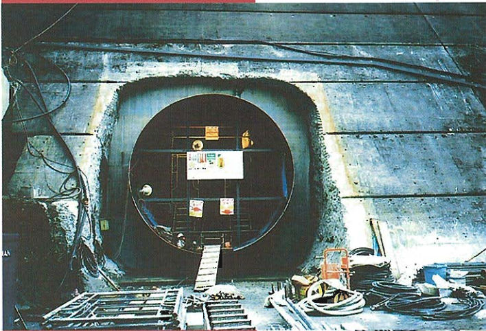
↑水圧鉄管据付・コンクリート打設後状況
