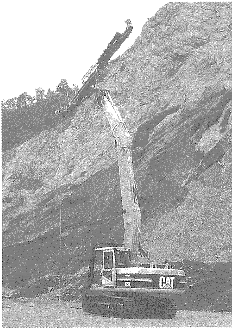
写真—9 ドリル搭載油圧ショベル
