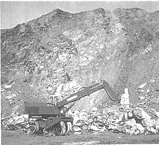
写真—6 昭和 40 年代の空圧ブレーカ作業
