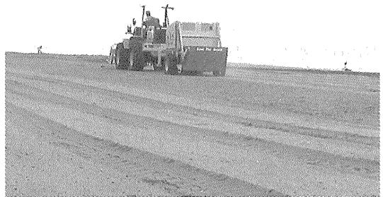
写真—6 稼働風景
