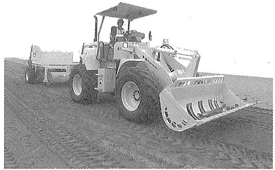
写真—5 稼働風景
