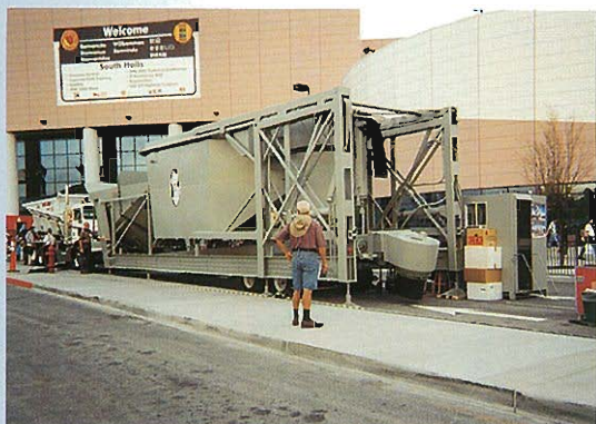
⇧ コンクリートプラントを横倒しにして格納しているところ
