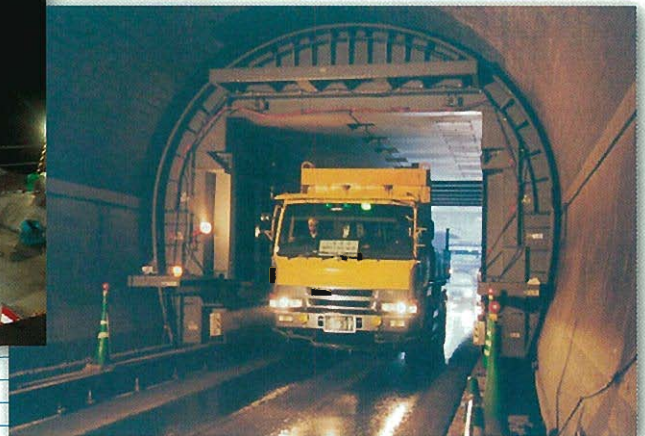
⇩ プロテクター内部車両通行状況
