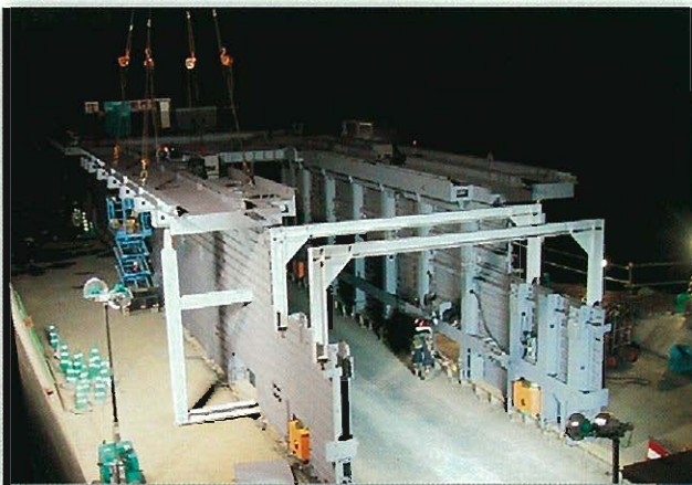
⇩ プロテクター組立状況
