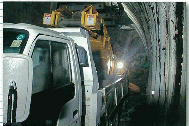
⇩下半ずり出し状況
