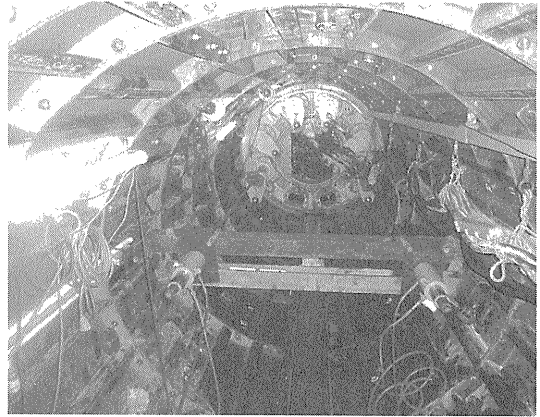
写真-6 分離状況（マシン内側）
